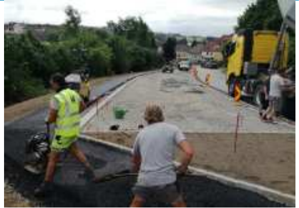
Asphaltierung des Parkplatzes bei der Ortseinfahrt
